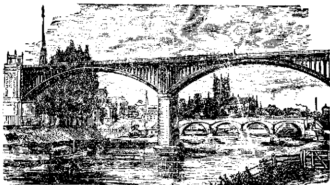
Puente sobre el Trent.
