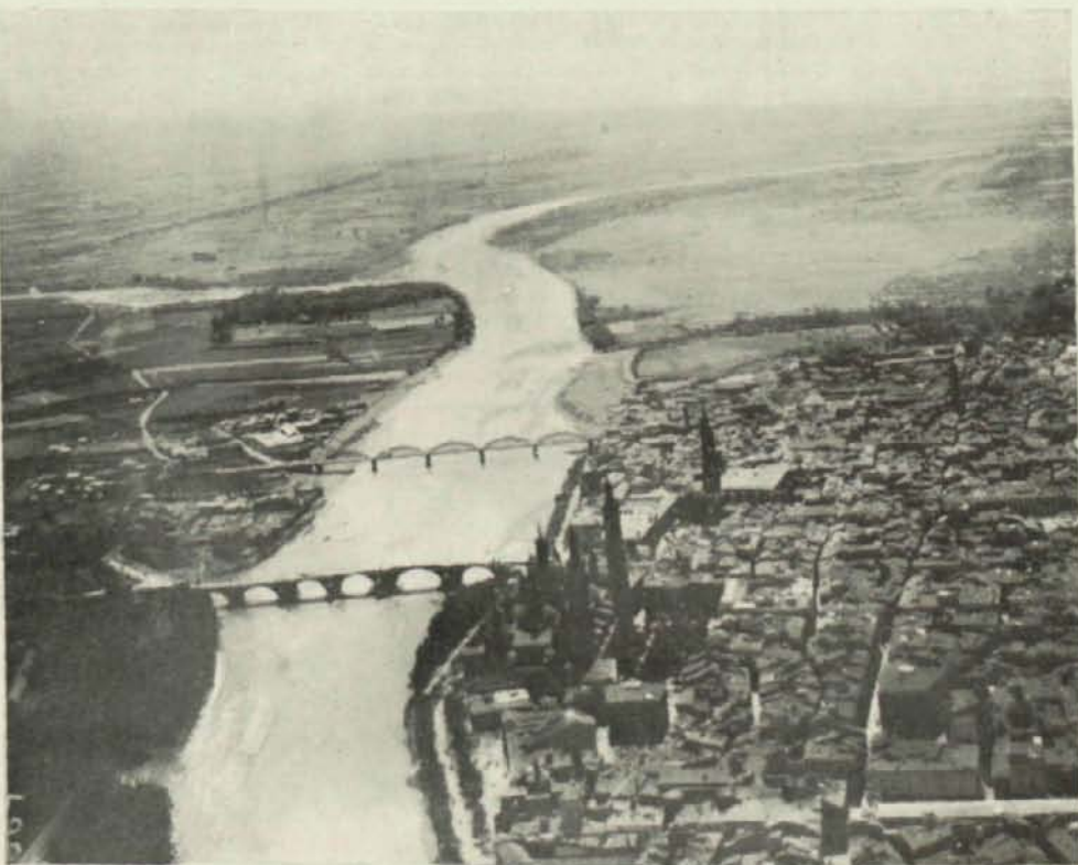
Zaragoza.—Vista parcial con los puentes sobre el Ebro
