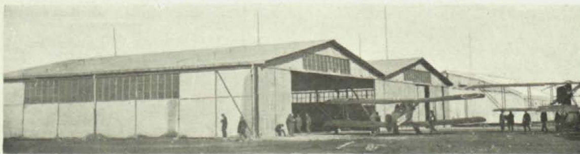
Hangar doble de la Escuela de Combate y Bombardeo Aéreo de Los Alcázares (Murcia)
