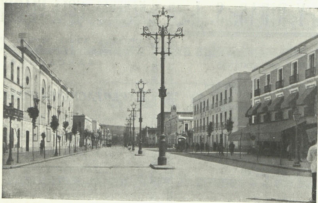
Avenida del Gran Capitán, Córdoba, pavimentada con loseta asfáltica C. P. A.
