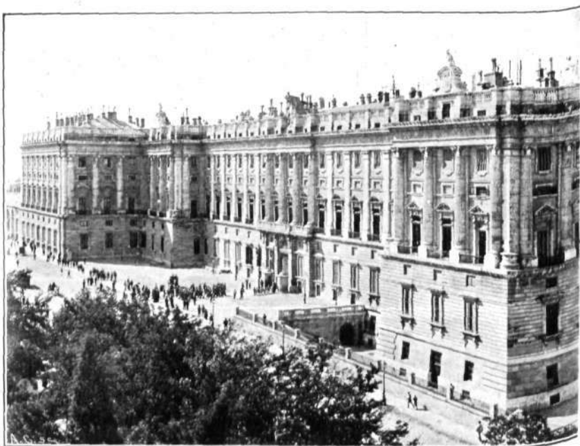
Palacio Real.—Fachada principal.
