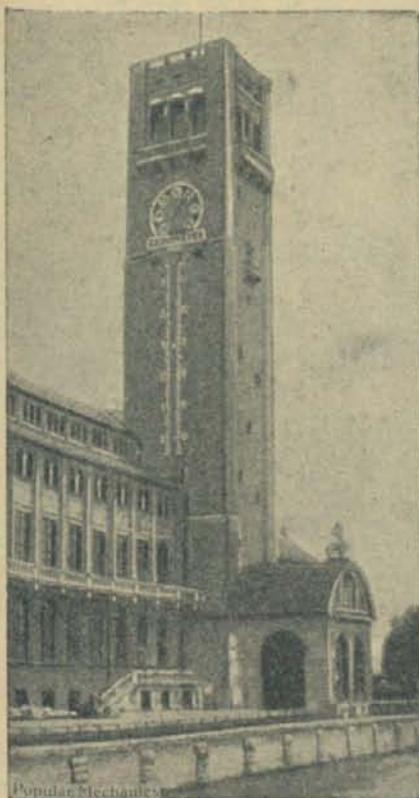
EN la torre del Museo de Munich se ha colocado un gigantesco termómetro coronado por un barómetro, visibles ambos a varios centenares de metros de distancia. El termómetro tiene, además, la particularidad de conservar una indicación de la temperatura máxima alcanzada en el día anterior y de la mínima a que ha descendido durante la noche. El termómetro, como puede verse en la fotografía, tiene la altura de una casa corriente de dos pisos y es en la actualidad el más grande del mundo.
