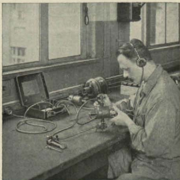
Aparato para verificar y examinar inducidos de aparatos de arranque, alumbrado y encendido.
