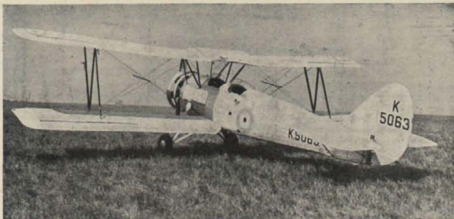
Nuevo modelo especial Havro 626, adquirido por las R. F. A. británicas, con objeto de emplearlo como aparato escuela en las instrucciones de navegación. Está dotado de cuantos elementos modernos son necesarios a tal fin, incluso cámara fotográfica
