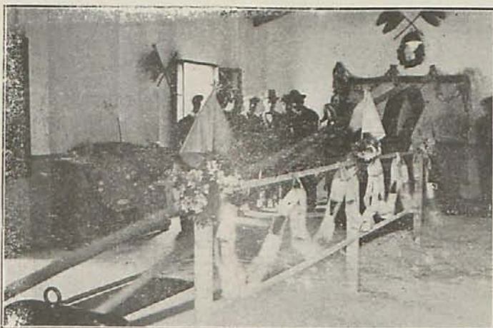
La sala de máquinas de la nueva Central.—Fotos Ferrer Pujol
