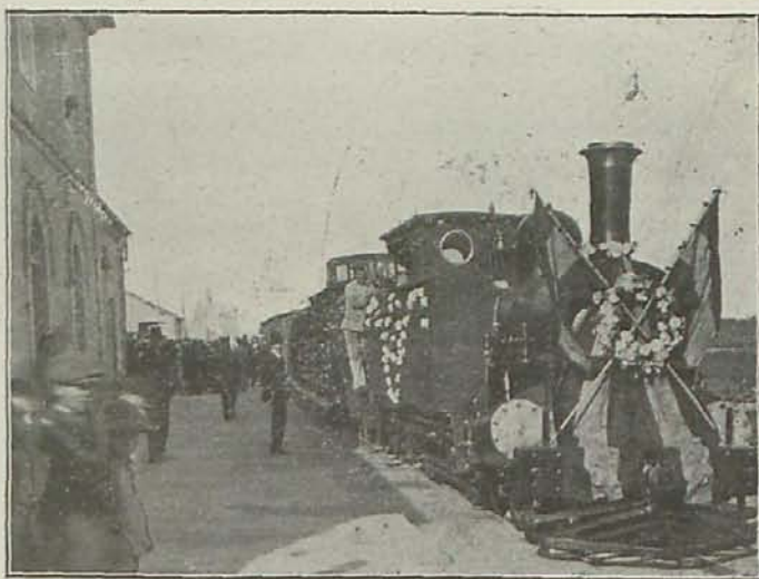
Llegada a Manacor del tren especial que condujo a los peregrinos
