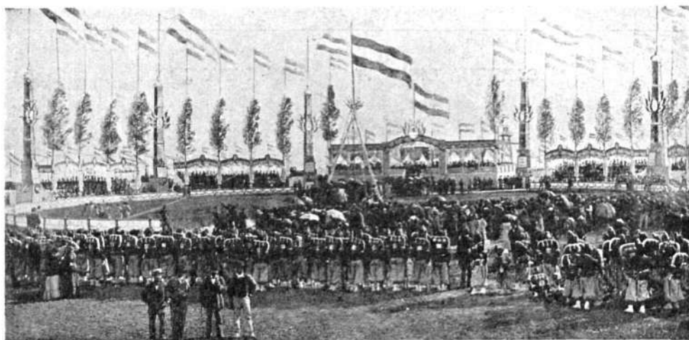
Colocación de la primera piedra
