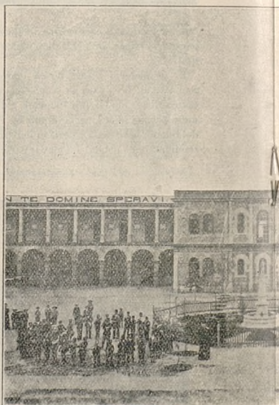
PATIO CENTRAL DEL C
