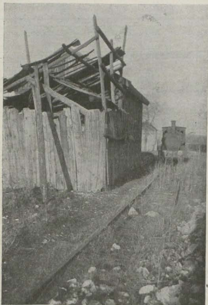
Estado en que se encuentran el material e instalaciones de Arlanzón
