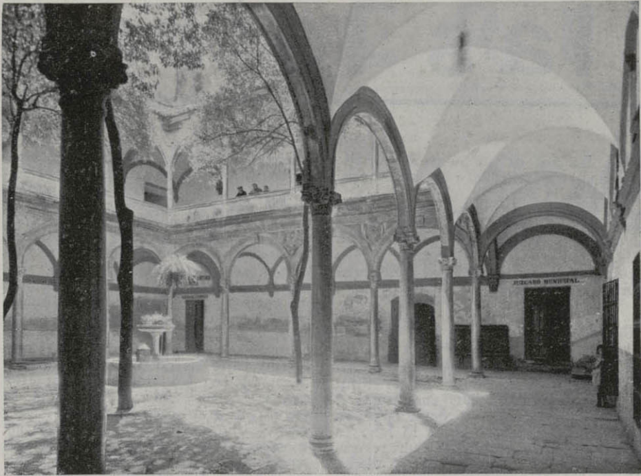
Ayuntamiento, antes Convento de Monjas Dominicas. Renacimiento. Siglo XVI. Obra de Vandelvira.
