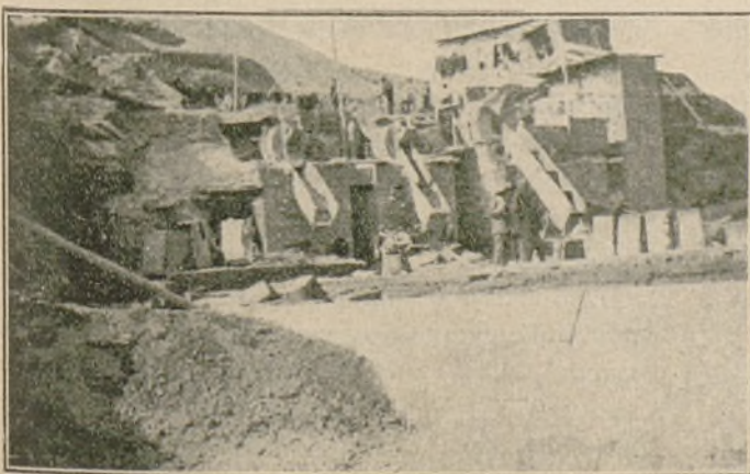
Presa de Puentes Viejas (en construcción).
