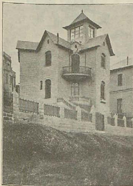
Chalet construido con bloques huecos de hormigón, para la Cooperativa de Periodistas para la Construcción de Casas Baratas
