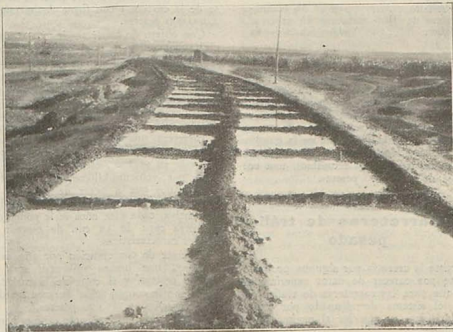
Se favorece el fraguado con una capa protectora de agua
