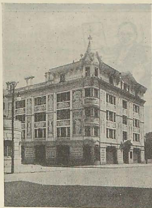
Edificio para oficinas en la Via Layetana (Barcelona)
