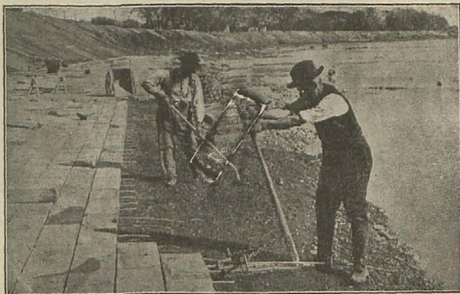
Colocación de los bloques que forman la colchoneta interior
