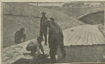
Colchoneta organizada con bloques de hormigón
