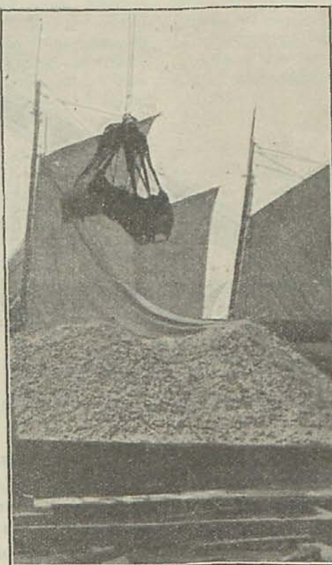
Grúa pronta a cargar piedra de una gabarra
