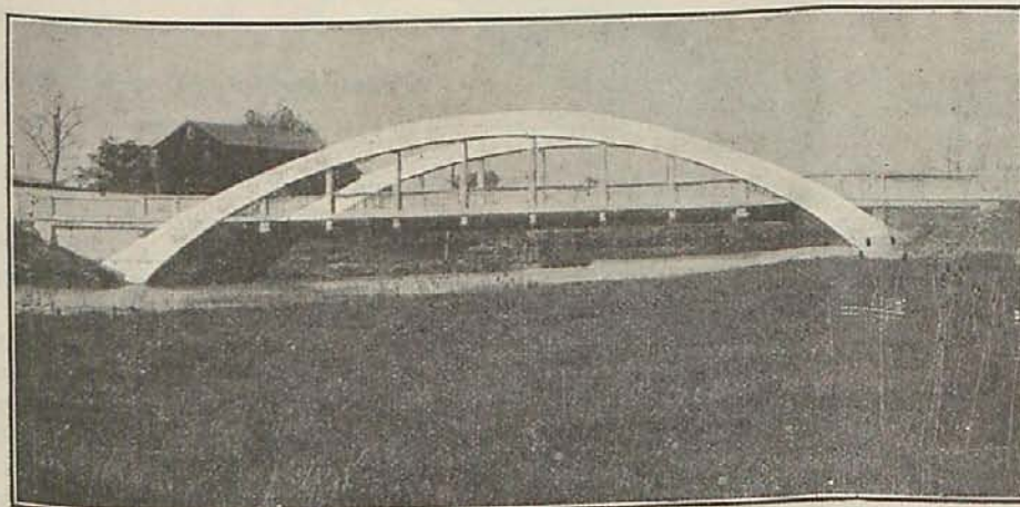
Otro de los puentes construido por el Estado de Ohio, en el país de Crawford
