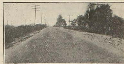
Una sección de la carretera de Cuyaboga
