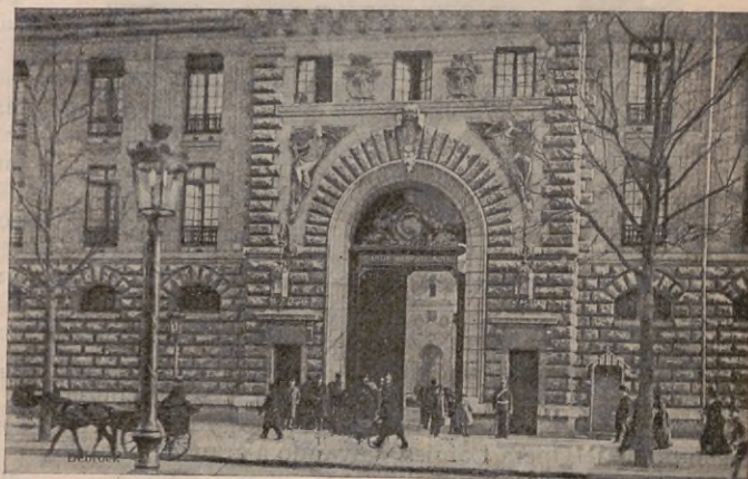
Puerta principal del cuartel.
