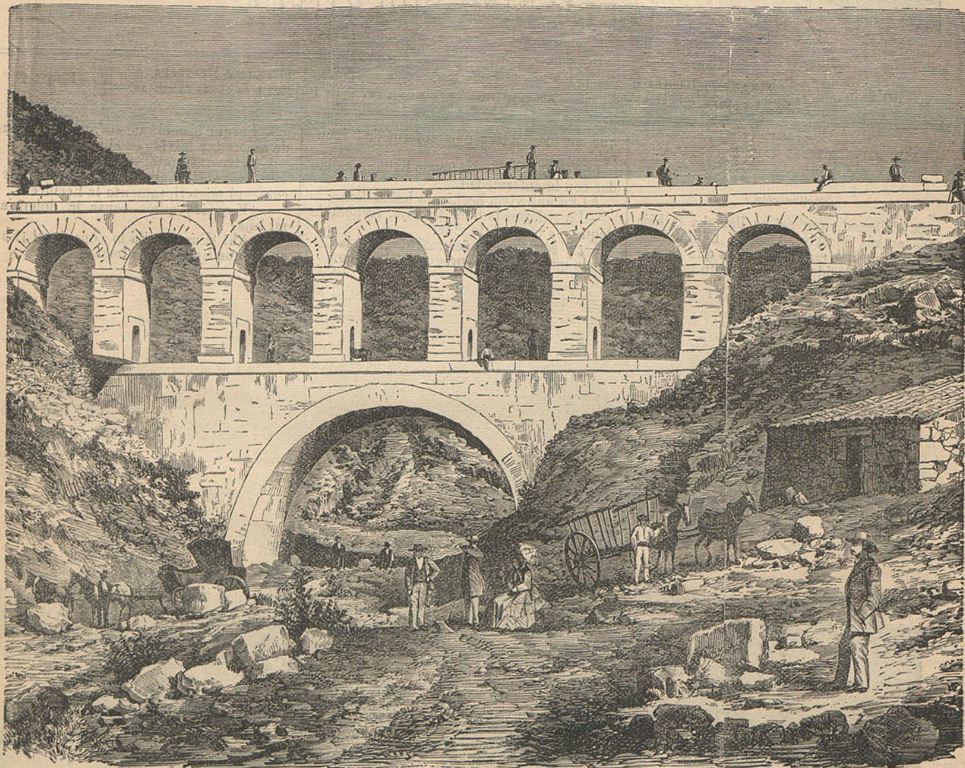
Acueducto de la sima, en el Canal que conduce á Madrid las aguas del río Lozoya.
