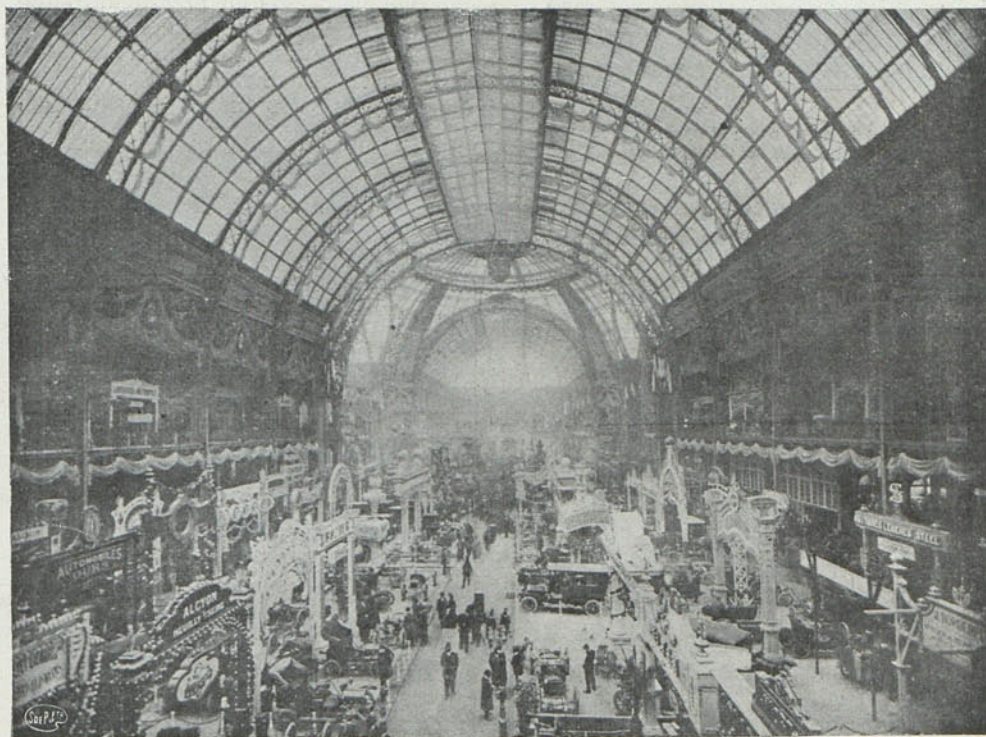
Vista general de la gran nave.
