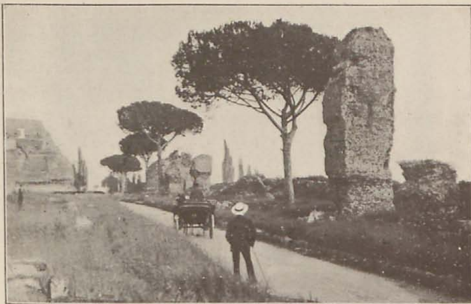
VIA APIA.—RESTOS DE CONSTRUCCIONES ROMANAS, ORNADA CON PINOS Y CIPRESES
