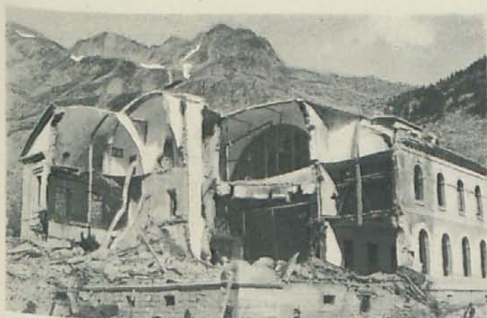
RUINAS DEL GRAN CASINO DESTRUIDO POR EL ALUD
