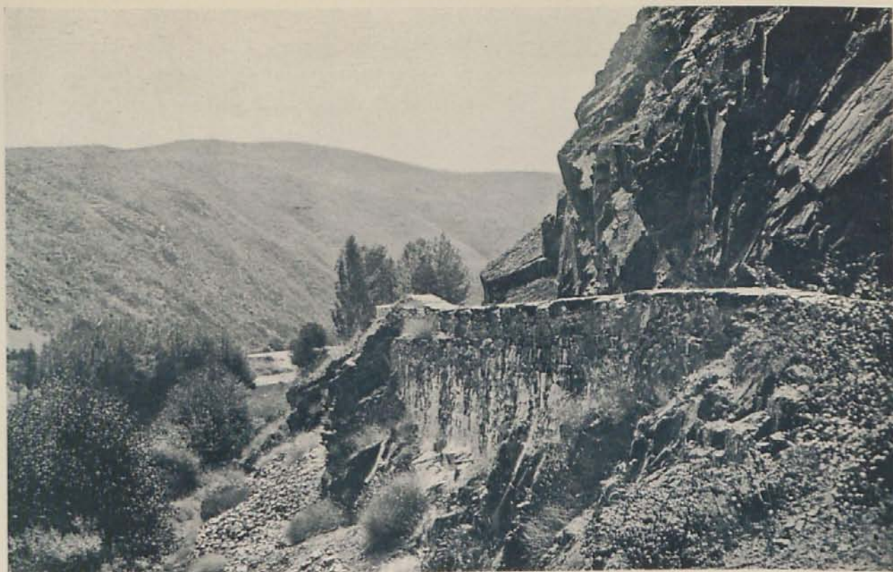
Camino de la presa de la Parra.
