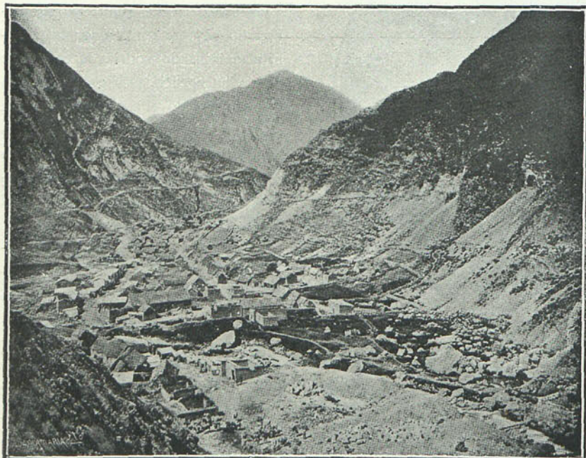
PERÚ.—Aldea de Chiclay, sobre el ferrocarril de Oroza; 12.200 pies sobre el nivel del mar
