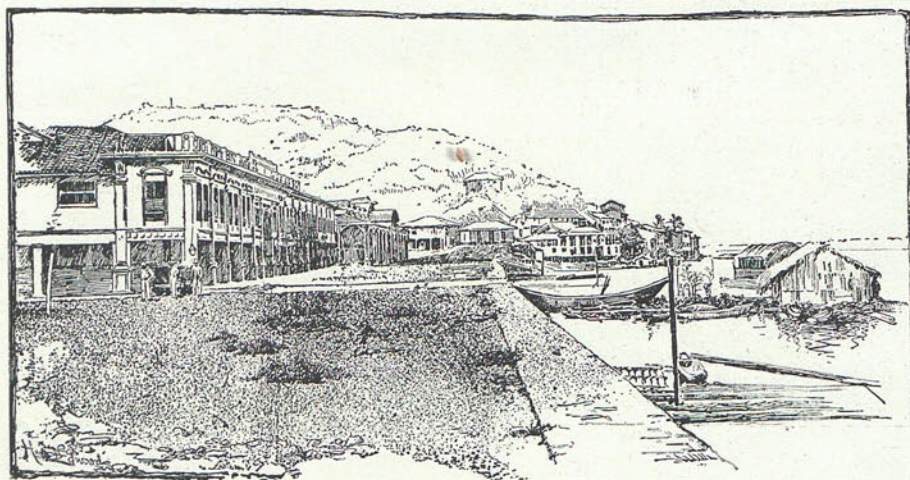
Aduana y Dique de Guayaquil.
