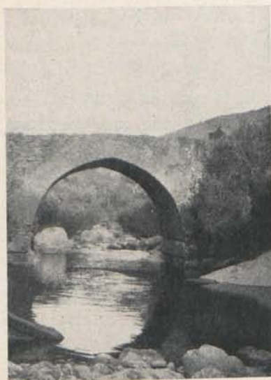
Puente sobre el río Tagsut.
