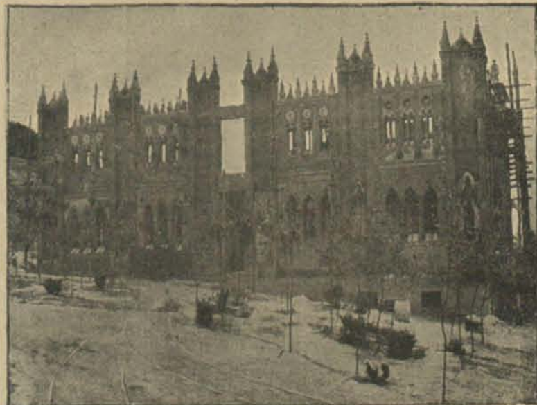
Iglesia en construcción.
