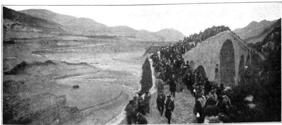
ZARAGOZA.—Inauguración oficial de los trabajos en el pantano de la Peña.
