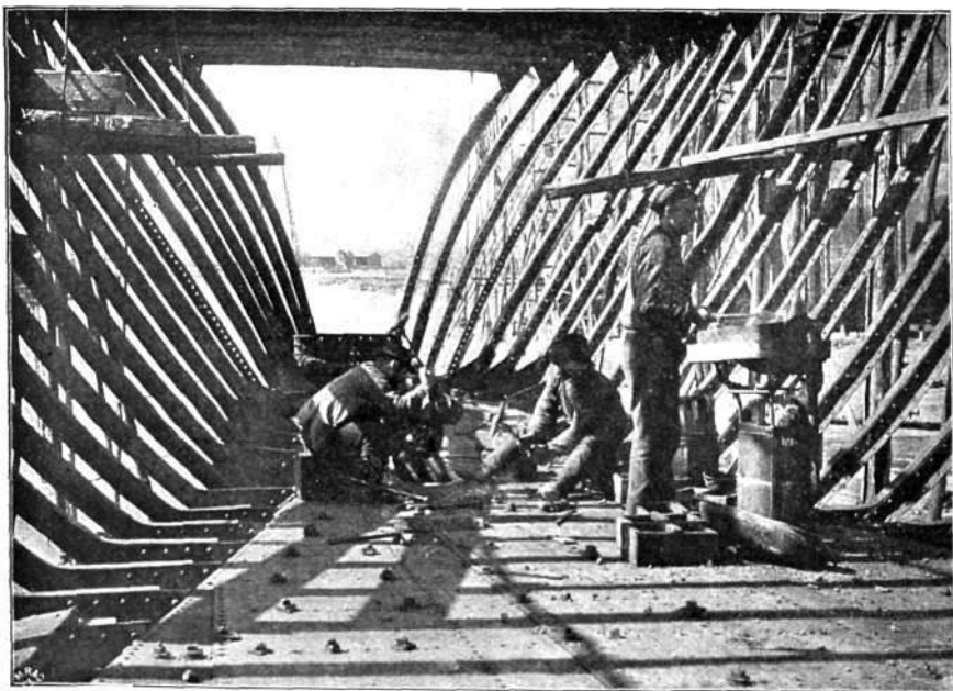
Fig. 5.—Remachadores trabajando en la cala de un vapor hamburgués.
