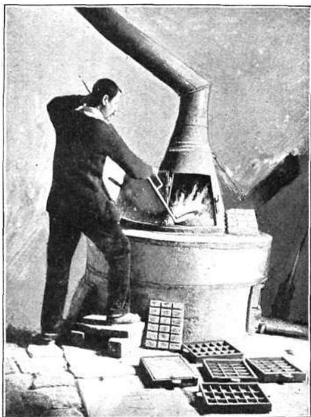
Los hornos para la fundición de los tres metales que entran á proporción en lo que se llama *régulo de antimonio*, están hechos especialmente para el objeto y se cargan con carbón de cok. Ya bien fundido el metal y limpio de la escoria que se forma en la superficie, el obrero dispone las lingoteras cerca del horno, como se ve en la fotografía, y las va llenando. Una vez frío el metal, adquiere la forma del molde en que cayó, y de este modo se obtienen los panes con que se fabrica luego la letra.
