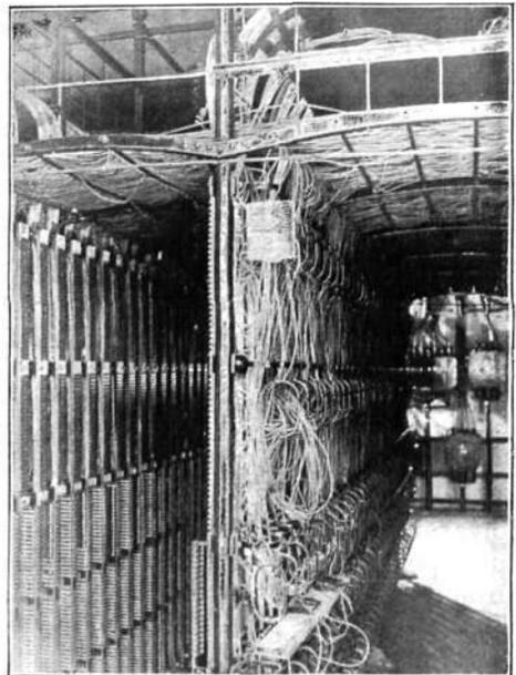
FIG. 3. Subterráneo en donde convergen los cables eléctricos que llegan del exterior para ser dirigidos desde allí á la cámara de distribución.
