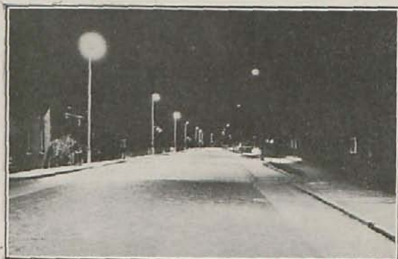
Carretera de Vught (Holanda), PHILORA 100 W.
