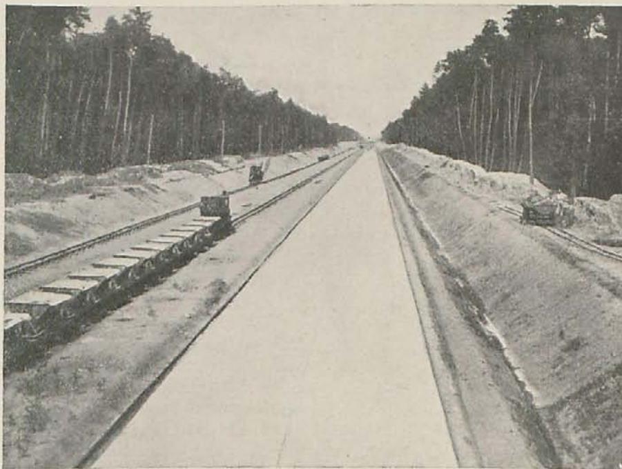
Aspecto de la autovía con una calzada terminada y la otra en construcción. Se advierten las extraordinarias dimensiones de la obra, la junta longitudinal de hormigonado y la disposición general.
