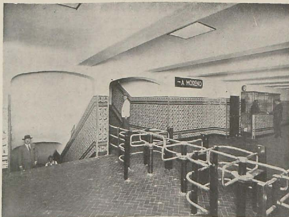
Vestíbulo de la estación Moreno.
