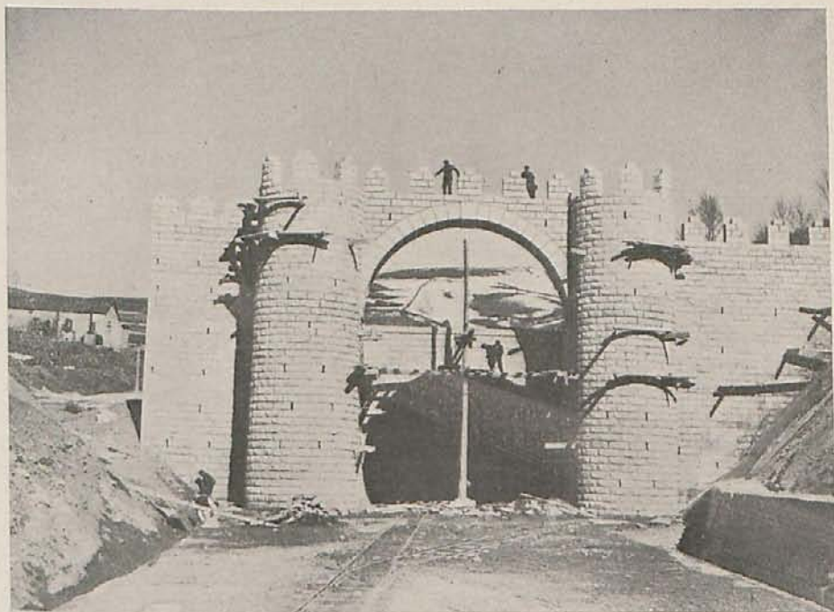
Boquilla Sur del túnel de Somosierra.
