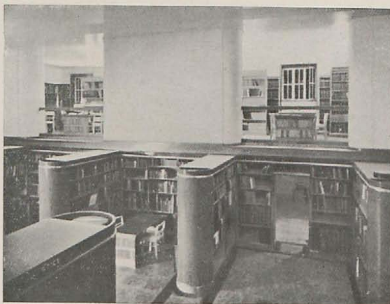
Biblioteca con la sala de lectura al fondo. Los extremos redondeados de las librerías son radiadores y contienen igualmente los elementos de alumbrado indirecto.
