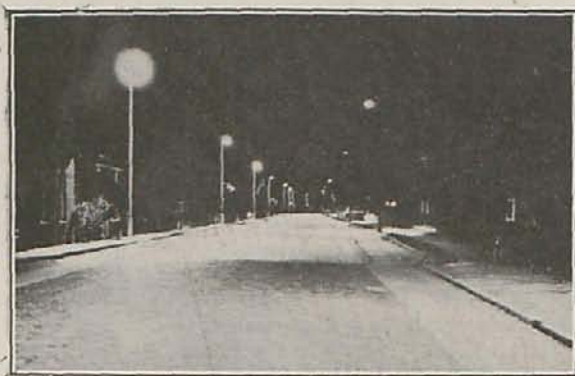
Carretera de Vught (Holanda). PHILORA 100 W.
