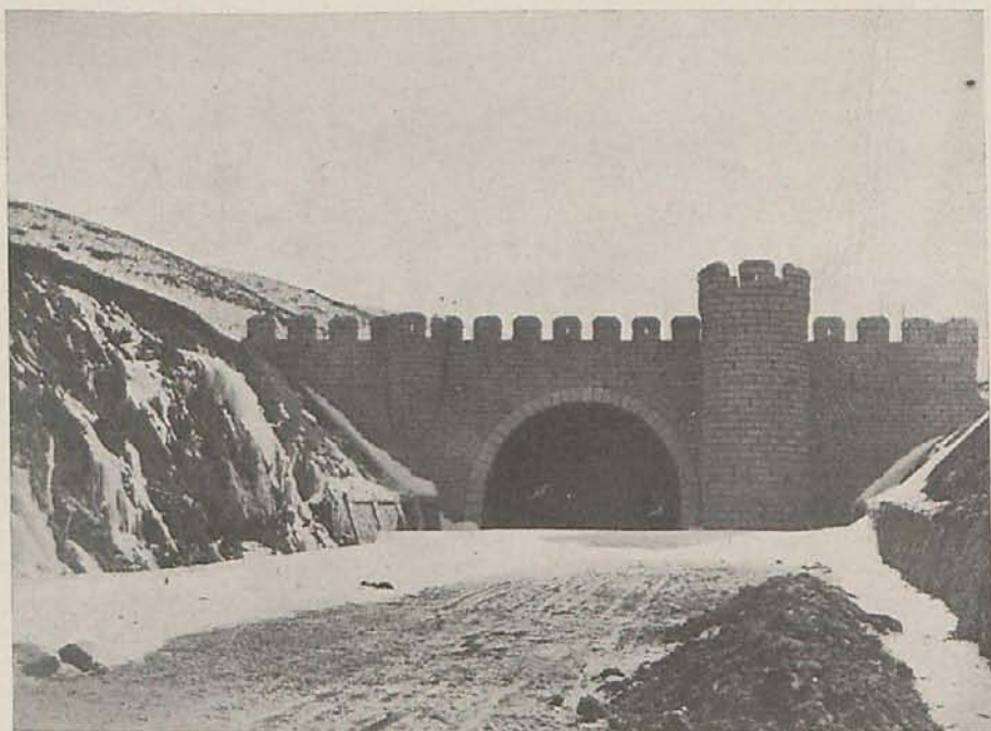
Boquilla Norte del túnel de Somosierra.
