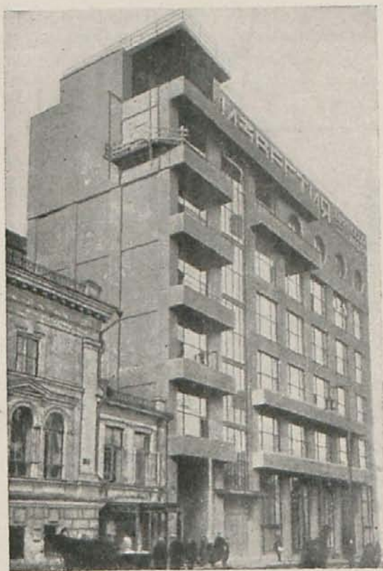
Fig. 16.-Barchin. Edificio del periódico "Izvestia", Moscú.
