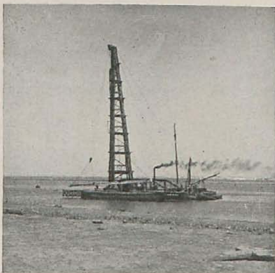
Fotografía (E).--Levantando un pilote de la gabarra.
