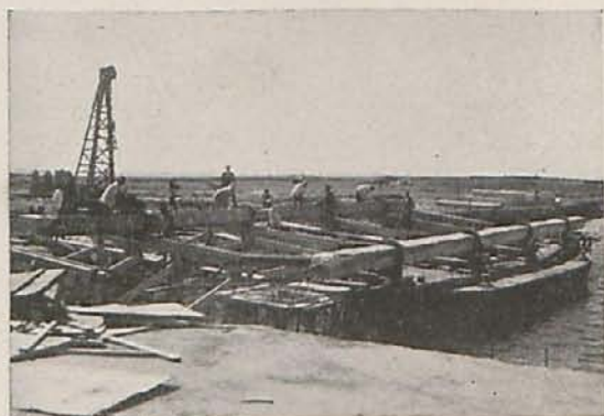
Fotografía (B).—Carga de los pilotes sobre gabarra.
