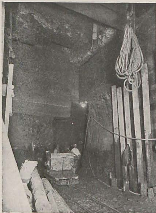
Trabajos de recalce de los muros del escenario.
