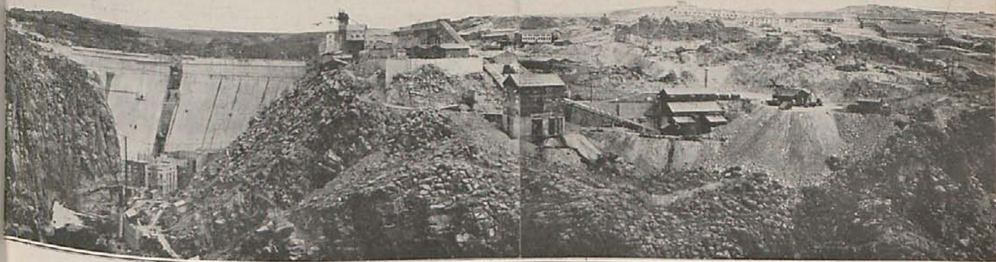
Las obras del salto del Esla en el verano de 1933. En el centro de la presa el portillo que se dejó para el paso de las aguas durante la construcción.
