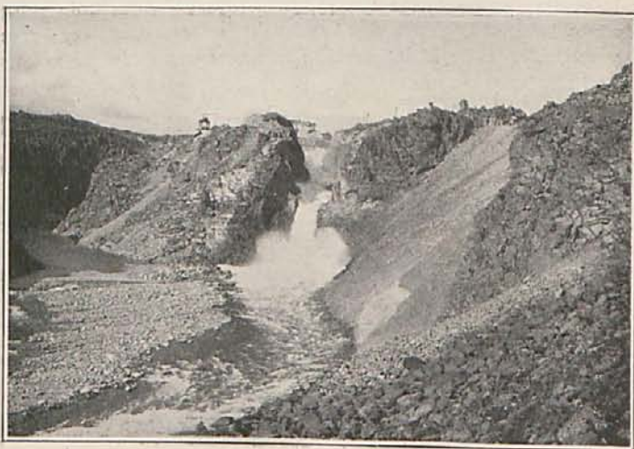
Canal del aliviadero, donde vierte en el río.
