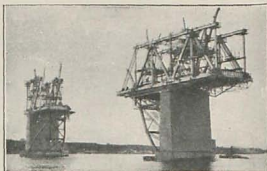
Fig. 14. — El montaje más avanzado, a partir de las pilas 3.ª y 4.ª
