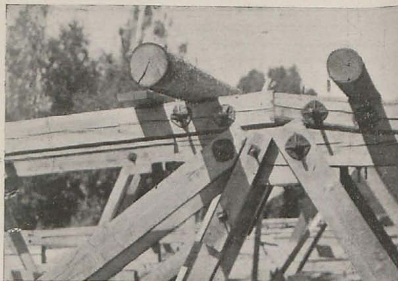
Detalles de las cabezas de los conectores G. S. que permiten emplear piezas rajadas, lo que no podría hacerse con los antiguos pasadores.
