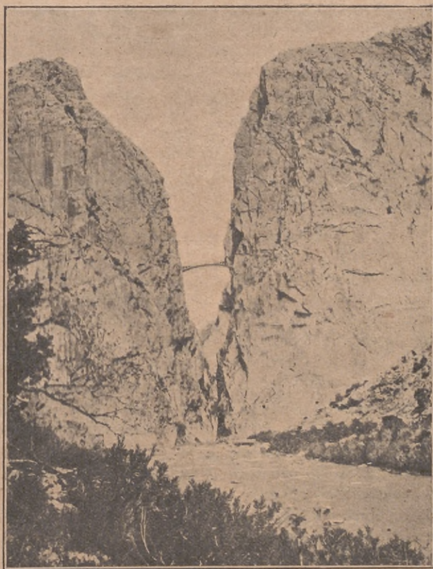
Vista del puente acueducto.
