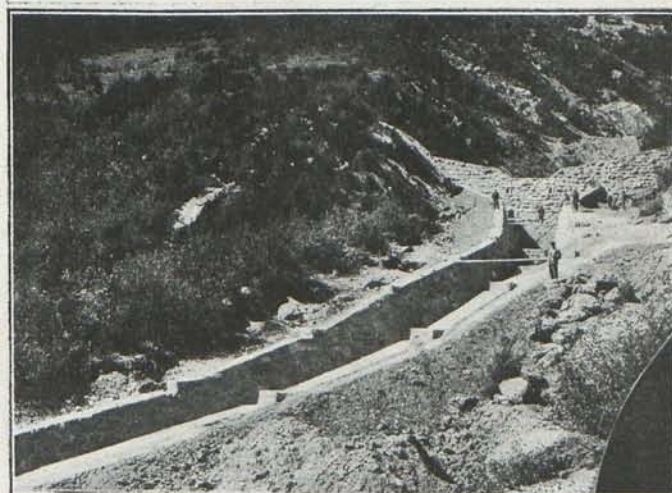
Torrente Estiviellas. Dique núm. 1 y origen de la canalización.
