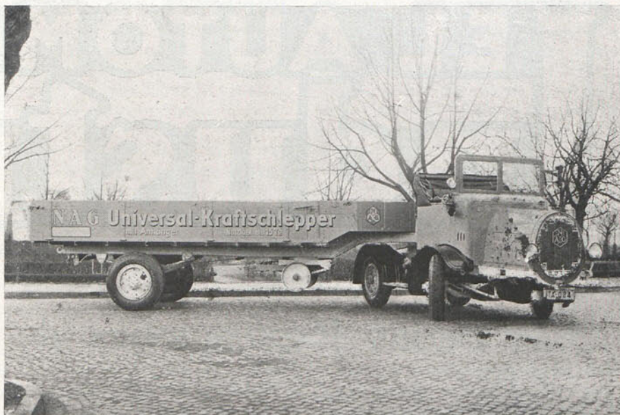
Un tren NAG para carga de 15 toneladas. Por estos sistemas y otras combinaciones análogas se orientan actualmente los transportes de grandes masas
