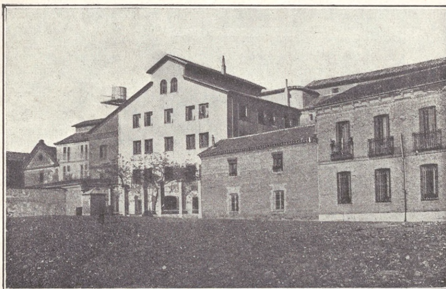
Fachada del Establecimiento
