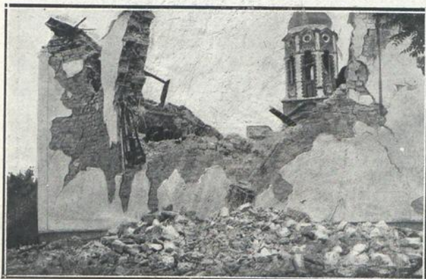
La iglesia de la Trinidad de Gorna-Orechovitz, desplomada
