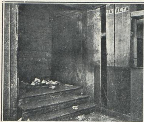
Trágica escalera que conduce a las galerías (Fotogs. Santaló)
