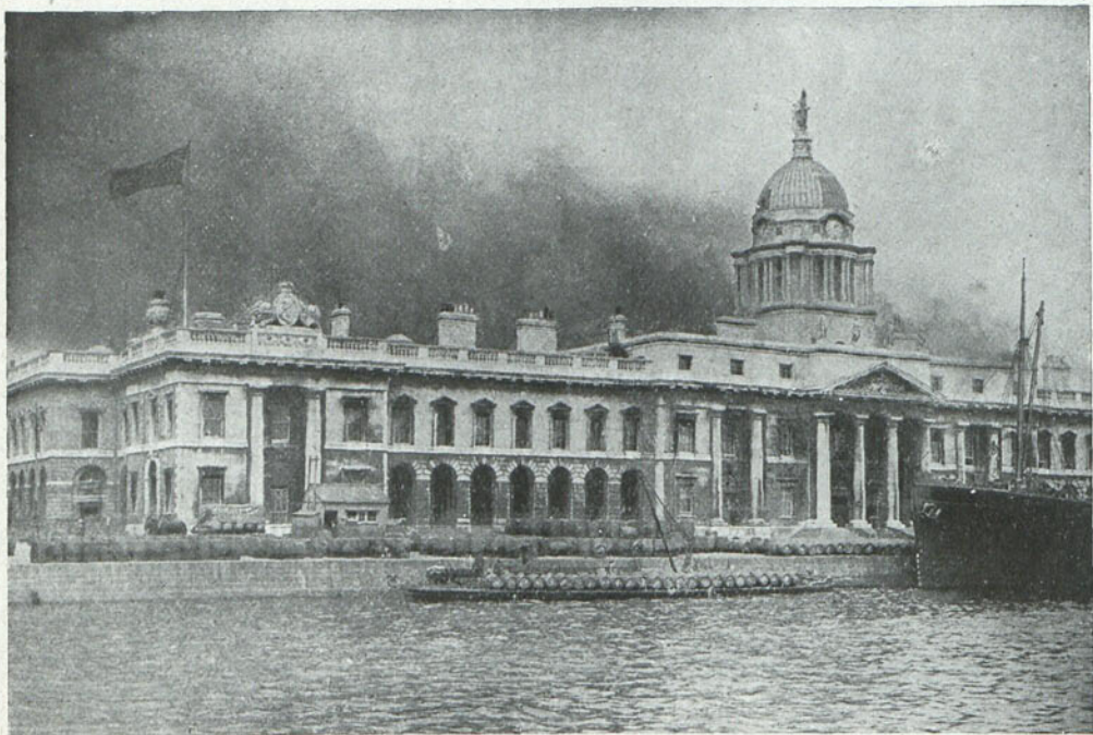
El edificio de la Aduana de Dublin incendiado por los fenianos, que había costado cincuenta millones de pesetas y que ha quedado destruido por el fuego.
