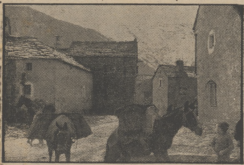
Un pueblito del frente de Aragón.—Eos muros rinden también una utilidad en la guerra, transportando vituallas, municiones, armamentos, etc., a las trincheras de V. angaria.
