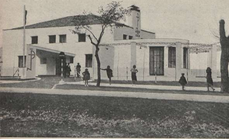
Exterior de un albergue de carretera.
